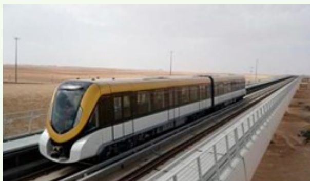
Primera prueba de circulación de trenes en la línea principal en modo manual.
